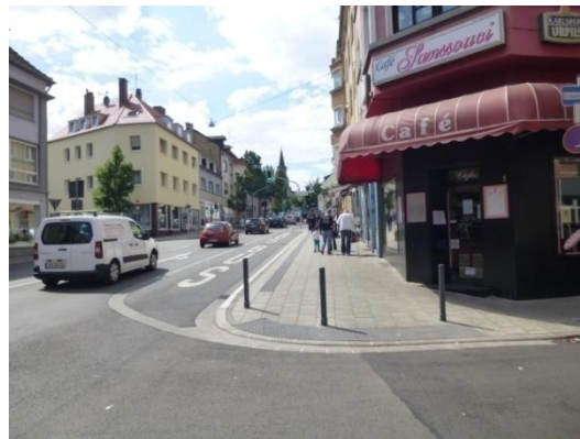
Abbildung 80: Barrierefreier Umbau des Kreuzungsbereichs und der Bushalttestelle an der Bergstraße (Burbach)
