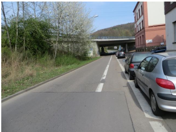
Abbildung 98: Unterbrochene Markierungen auf der Dudweiler Landstraße
