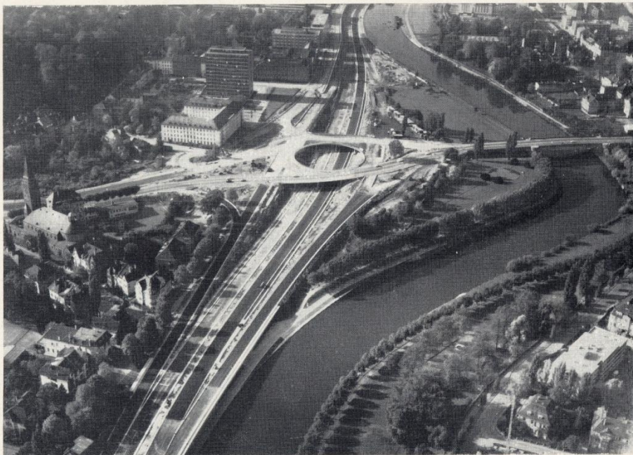
Anschlussstelle Bismarckbrücke Zustand 1960 und Oktober 1963
