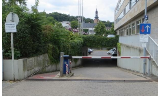
Abbildung 85: Zufahrt Leinpfad auf Alte Brücke/Höhe Finanzamt
