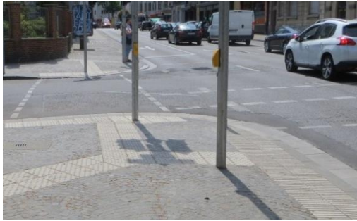
Abbildung 52: barrierefrei ausgebaute Fußgänger-LSA (Sulzbachstr./Richard-Wagner-Str.)
