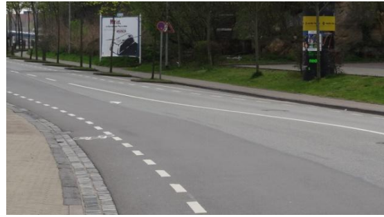
Abbildung 101: Schutzstreifen auf der Gersweiler Straße
