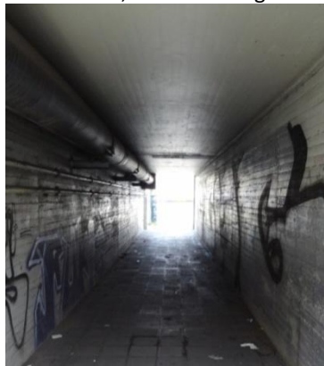
Abbildung 95: Südseite A620 Höhe Messe, Unterführung
