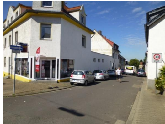
Abbildung 74: kurze einseitige Gehweglücke (Blumenstraße in Altenkessel)
