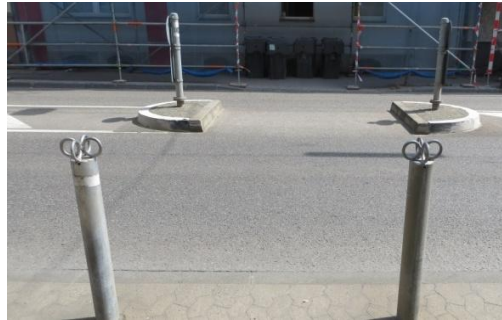
Abbildung 53: Querungshilfe ohne taktile Leitelemente (Richard-Wagner-Str./Karcherstr.)
